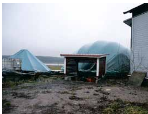
➤ Биогазовая установка в колледже
