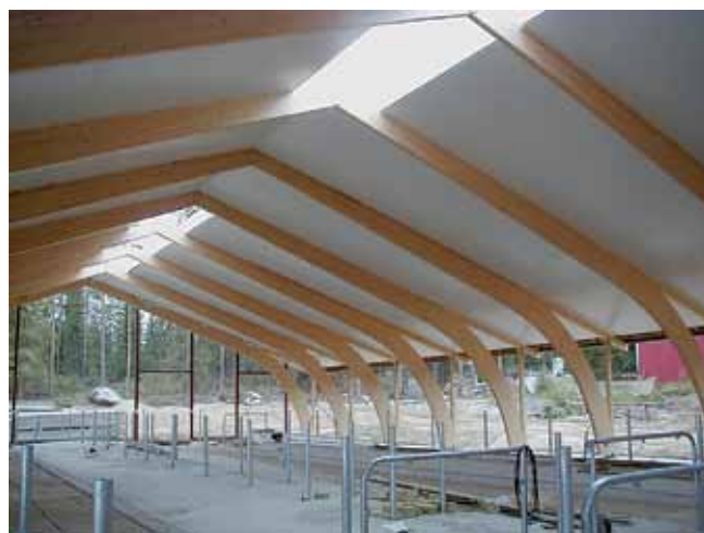
◀ Фото 1. Двор беспривязного содержания, балки из клееной древесины и колонны из стальных труб (К. Brännäs 2006)
