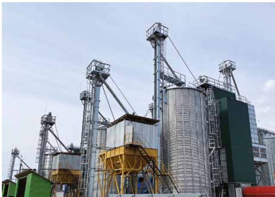
▲ Зерносушильный комплекс ЗСК-40ШГ в Псковской области
