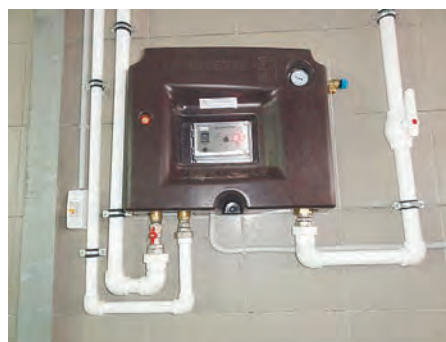
Устройство для подогрева и циркуляции воды, подаваемой в поилки
