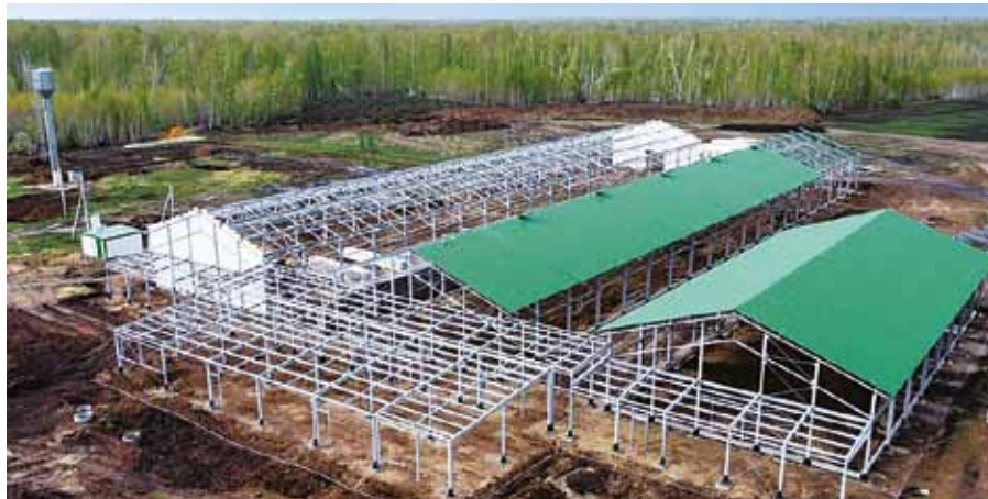
Группа компаний «Дамате» высокими темпами ведет строительство крупнейшего в России племенного репродуктора индейки второго порядка мощностью 12 млн яиц в год в Исетском районе Тюменской области. Стоимость проекта — 5,2 млрд рублей.
