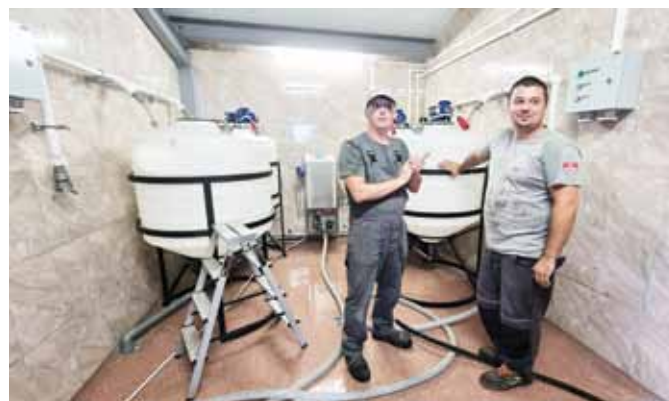
➤ Монтаж оборудования в профилактории для тёлочек
