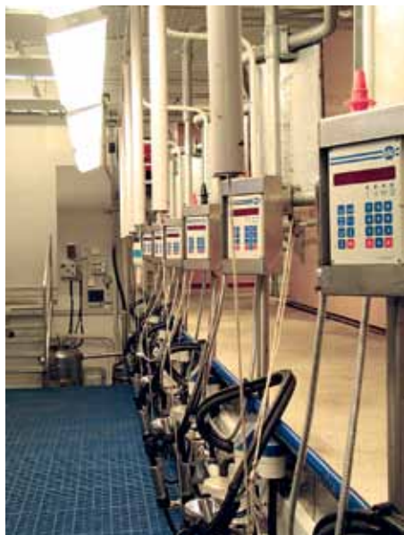
Вымя должно быть хорошо освещено, чтобы доярка следила за чистотой сосков. Для этого светильники в доильном зале расположены под уклоном. Фото: Esa Manninen
