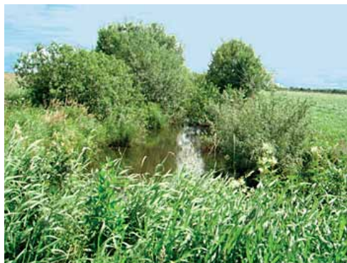
Открытые каналы осушительной сети, как и весь мелиоративный комплекс в Северо-Западном регионе РФ, находятся в неудовлетворительном состоянии
