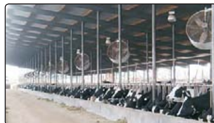
При круглогодичном боксовом содержании животных обязательно используется система принудительной вентиляции помещений, система вентиляторов.
