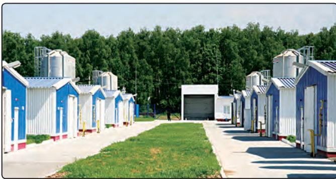
Но и здесь есть свои нюансы. Герметичность традиционных трехслойных «сэндвичей» с минераловатным сердечником хоть и высока, но не стопроцентна. К тому же регулярная мойка помещений, в конце концов, нарушает герметичность стыков панелей, что грозит их расслоением, намоканием утеплителя, ухудшением теплосберегающих характеристик и развитием грибковых образований. И здесь на выручку вновь приходят СП ПС, конструкция которых позволяет избежать подобных проблем.
